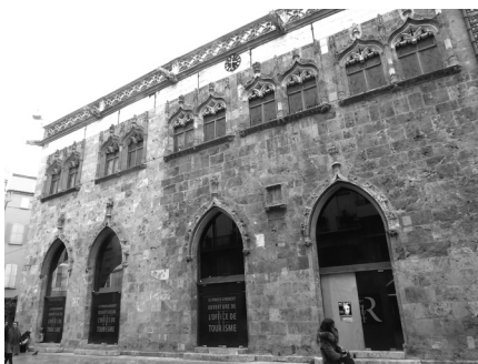
Fig. 2 - Aspecte actual de la façana principal (nord) de la Llotja. El color més clar de la pedra, a la banda esquerra, indica la part primitiva de l'edifici, del segle xv
