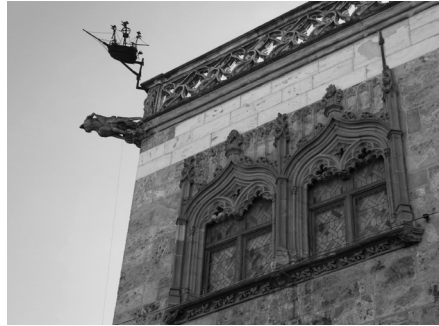
Fig. 10 - Aspecte de la façana nord: finestra restaurada, aixecament del 1842, balustre refet el 1909
